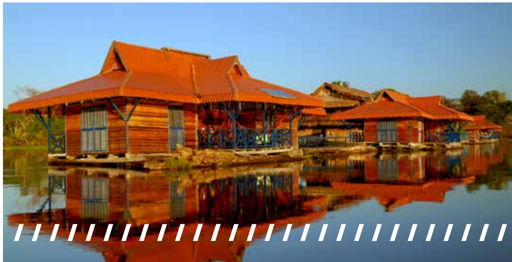
FIGURA 4.16: Visão externa dos módulos de hospedagem da Pousada Uacari.
