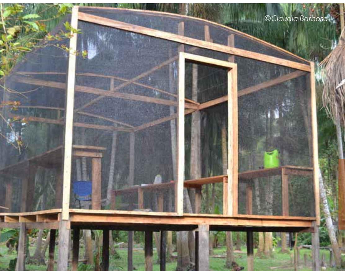
Viveiro construído na comunidade Barroso - Reserva de Desenvolvimento Sustentável Mamirauá.
