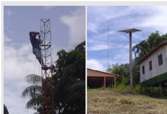
Instalação da torre da Rádio “A Voz da Selva” na comunidade de Boa Esperança - RDSA
